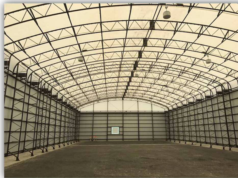
第1期販売分テント倉庫内部
