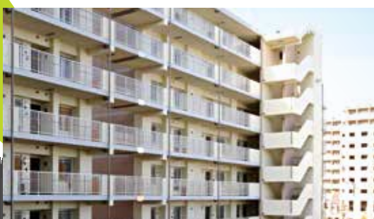
さいたま市市営春野団地建設(建築第三期)工事
