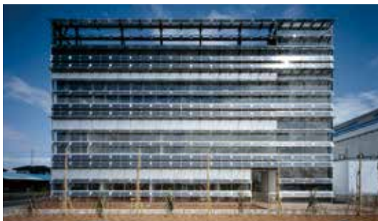
川越市保健所新築工事
