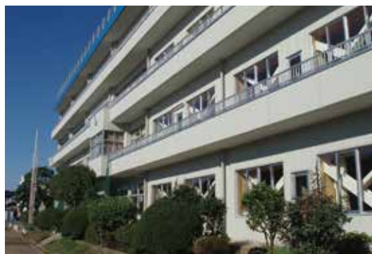
日高市立向原中学校校舎耐震補強等工事
