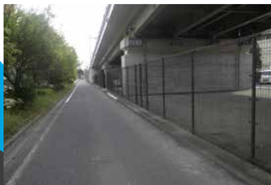
さいたま市南浦和陸橋耐震補強工事その2
