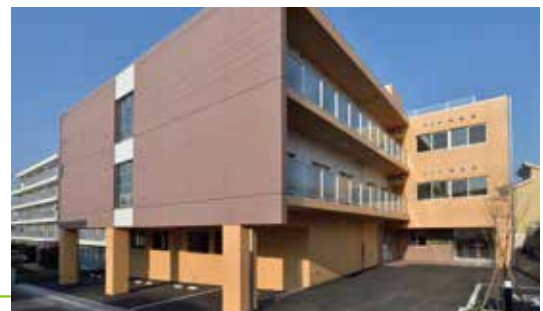
介護付き有料老人ホームみんなの家・三橋2丁目建築工事
