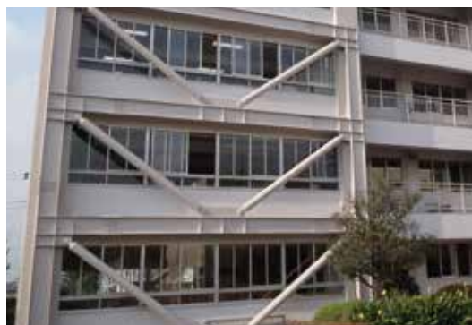
日高市立高麗川中学校北棟耐震補強改修工事
