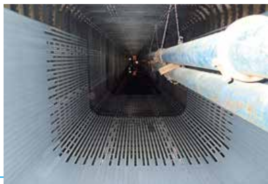
さいたま市鴨川第42処理分区下水道工事(南再-28-302)
