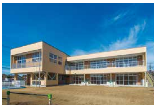
三芳町立第二保育所耐震補強工事
