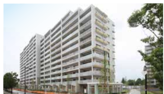
UR都市機構コンフォール松原7号棟建築工事
