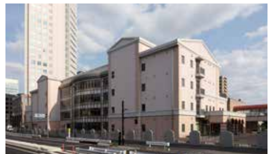
さいたま市立桜木小学校校舎改築工事
